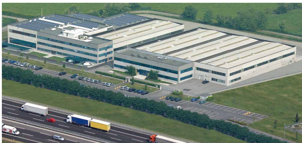
La sede di Maico Italia SpA a Lonato del Garda, Brescia.
